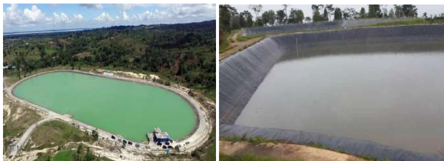
Gambar 4. Model embung untuk menampung air hujan dan dipanen pada saat musim kemarau
