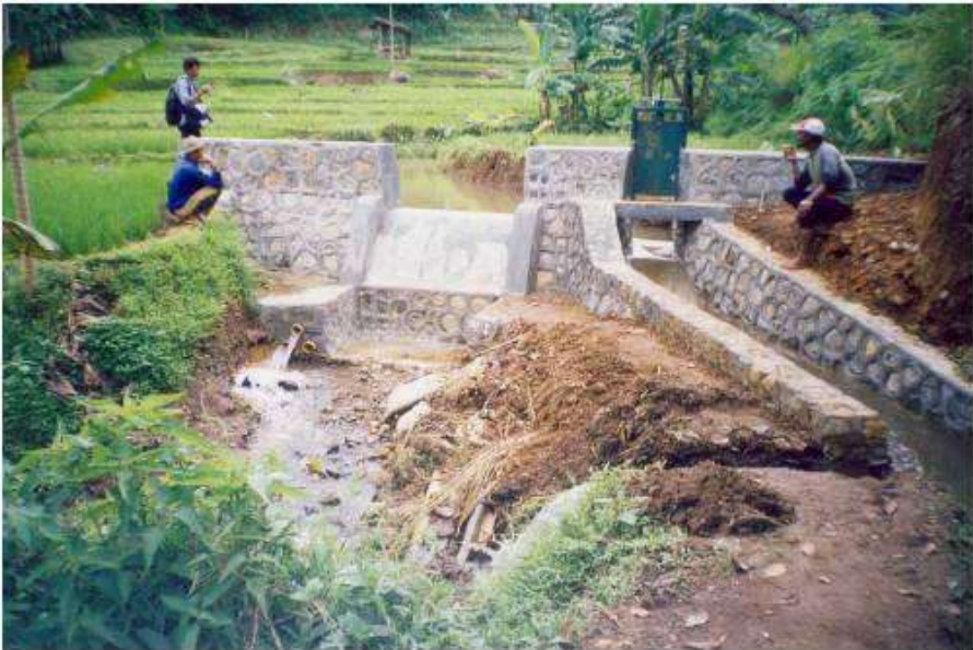
Gambar 13. Dam parit untuk menampung dan mengalirkan air
