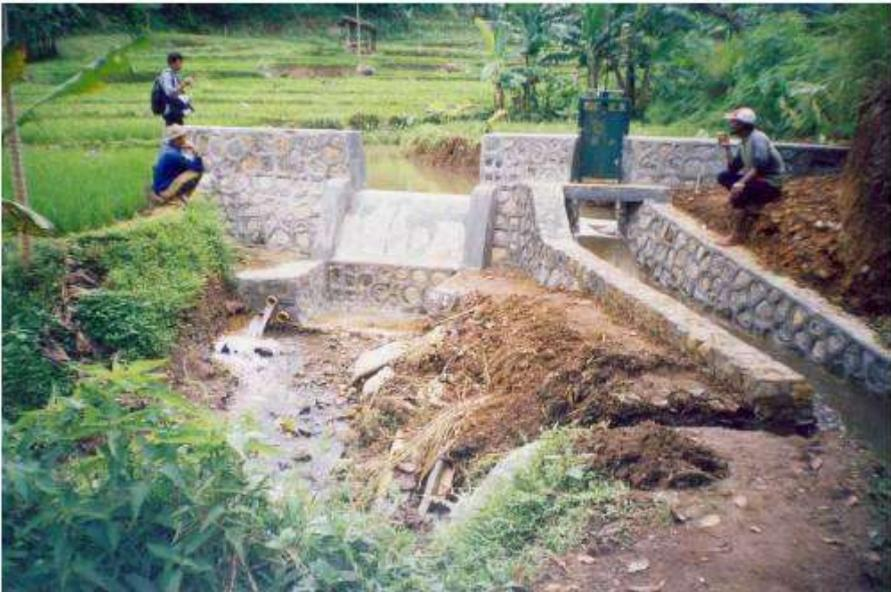
Gambar 13. Dam parit untuk menampung dan mengalirkan air
